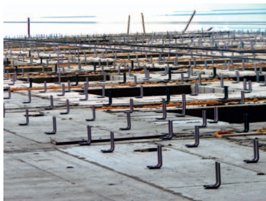
Монтаж кронштейнов НФС
