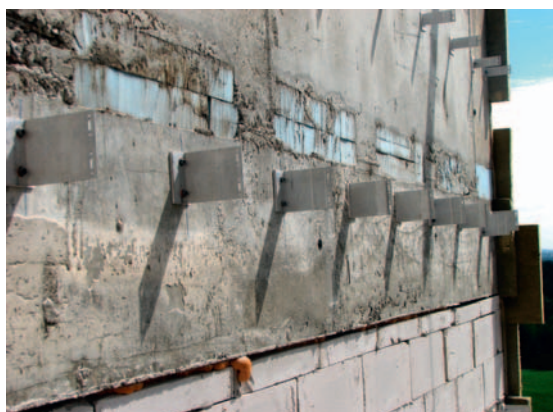
Монтаж кронштейнов НФС
