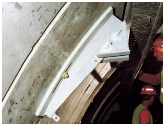
Монтаж тоннельных коммуникаций
