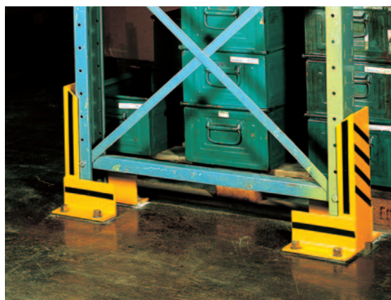
Монтаж складского оборудования
