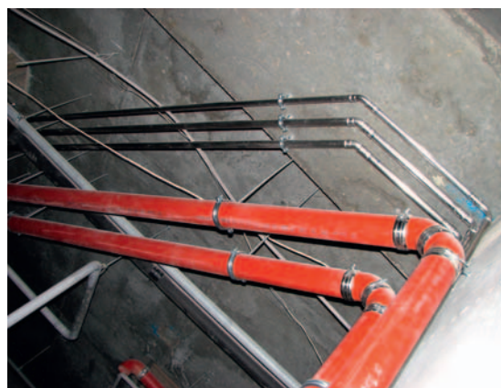
Монтаж тяжелых инженерных систем
