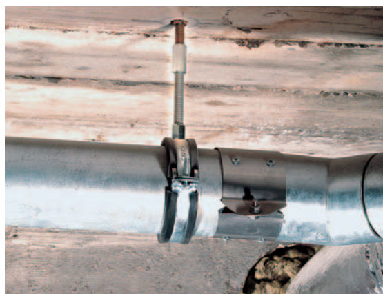
Монтаж тяжелых инженерных систем
