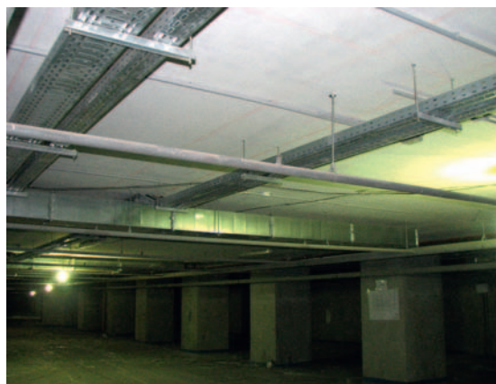
Монтаж тяжелых инженерных систем
