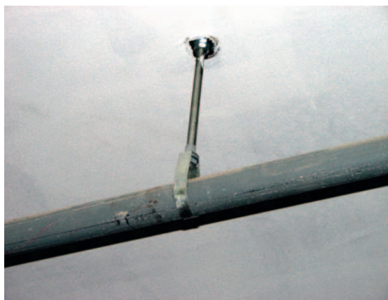
Монтаж тяжелых инженерных систем
