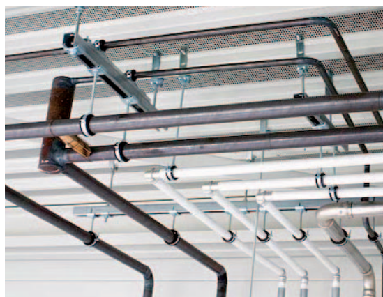
Монтаж инженерных систем
