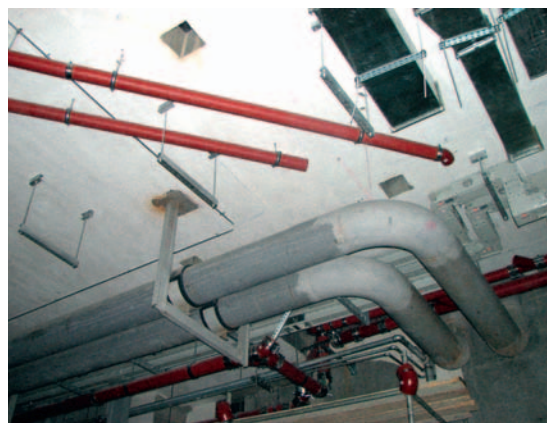
Монтаж инженерных систем
