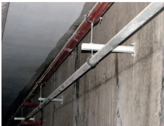
Монтаж инженерных систем
