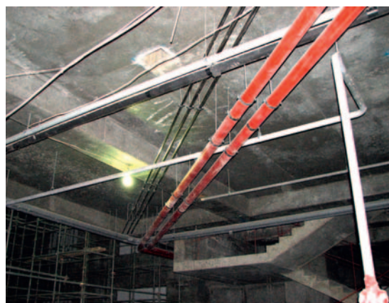
Монтаж инженерных систем
