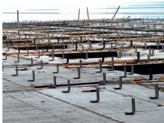
Монтаж кронштейнов НФС
