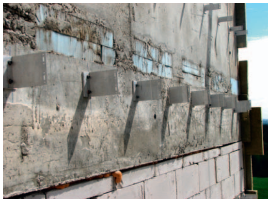
Монтаж кронштейнов НФС
