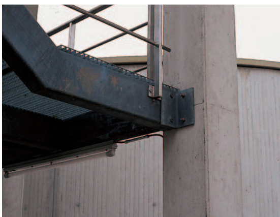
Монтаж лестничных маршей
