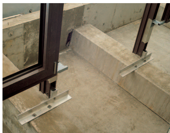
Монтаж витражных конструкций
