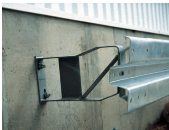
Монтаж дорожных ограждений
