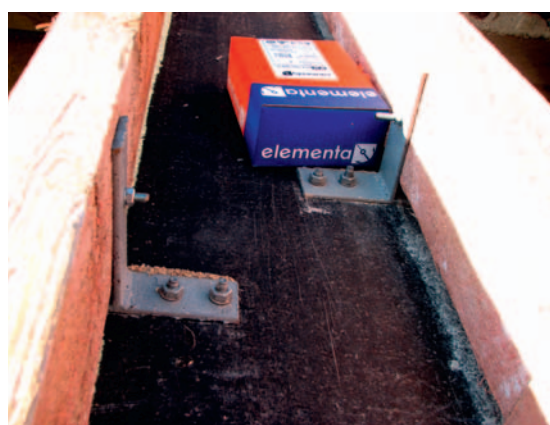
Монтаж стропильных балок
