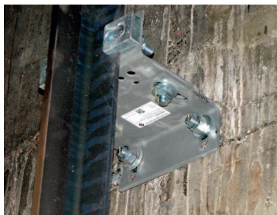
Монтаж лифтовых направляющих
