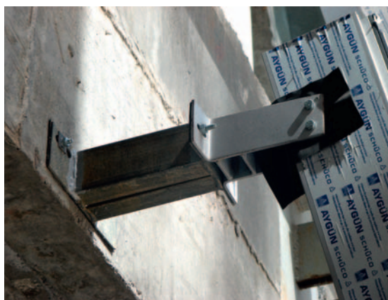
Монтаж светопрозрачных конструкций
