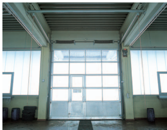
Монтаж автоматических ворот
