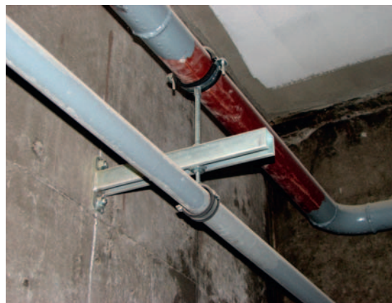
Монтаж инженерных коммуникаций
