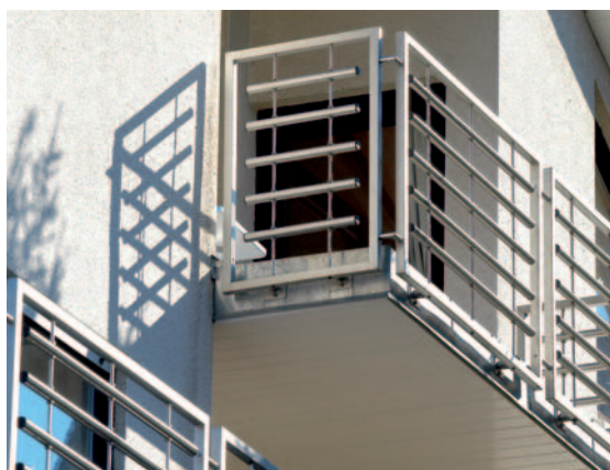
Монтаж балконных ограждений
