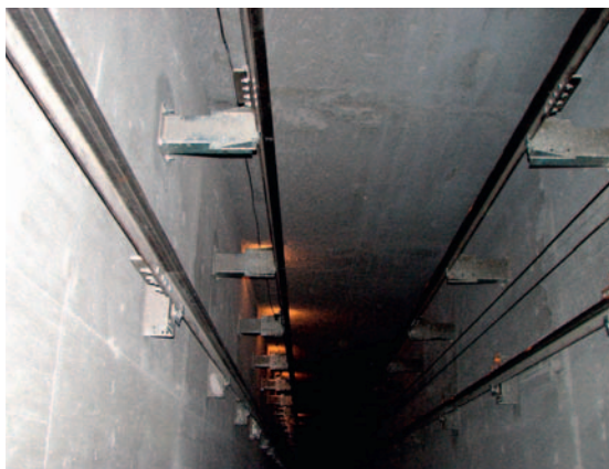
Монтаж лифтовых направляющих
