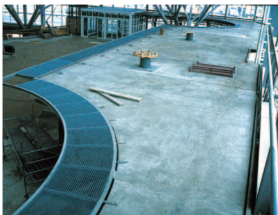
Монтаж малых архитектурных конструкций
