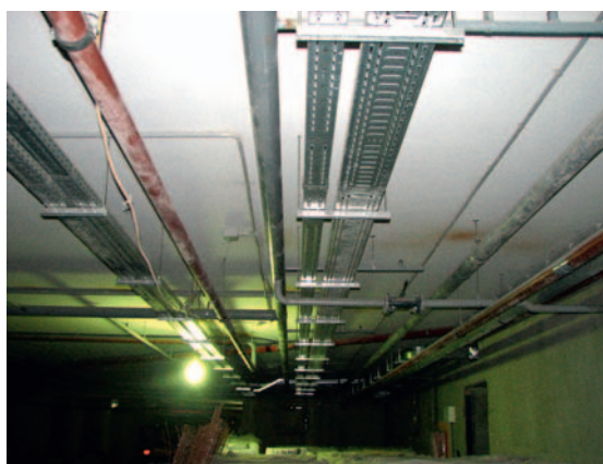
Монтаж инженерных систем
