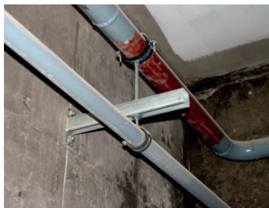
Монтаж инженерных систем
