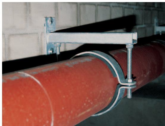
Монтаж инженерных систем
