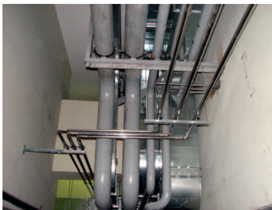
Монтаж инженерных систем
